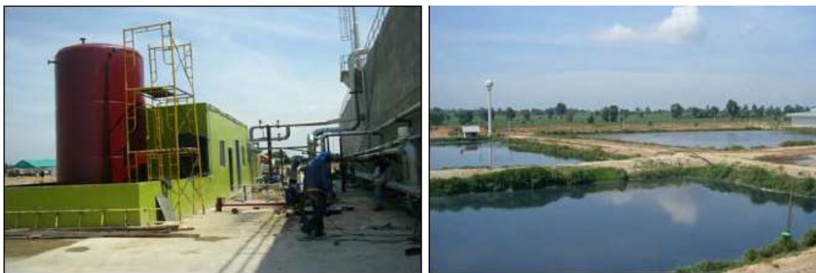
Fabrique d'amidon (ci-dessus) Installation de traitement des eaux usées (ci-contre, à gauche) et anciens réservoirs d'eaux usées (ci-contre, à droite). (Source: South Pole Carbon)
