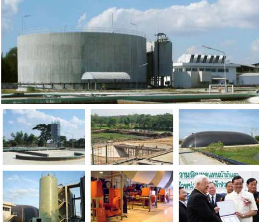
Photos de l'installation de traitement des eaux usées A Bangna e Thailand (Source : South Pole Group)
