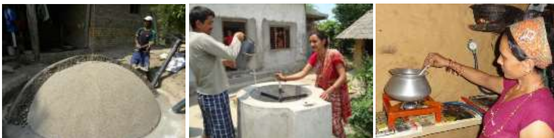
Installations de biogaz en construction et en fonctionnement, réchaud fonctionnant au biogaz. (Source: Atmosfair)
