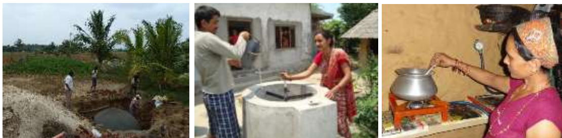
Installations de biogaz en construction et en fonctionnement, réchaud fonctionnant au biogaz (Source: Atmosfair)
