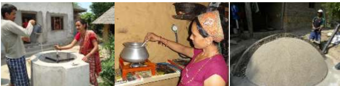
Installations de biogaz en construction et en fonctionnement, réchaud fonctionnant au biogaz. (Source: Atmosfair)
