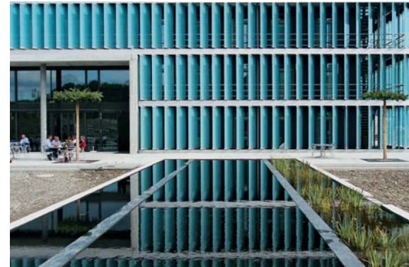
Restaurant du personnel et réservoir d'eau de pluie www.forumchriesbach.eawag.ch
