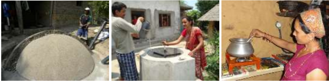
Biogasanlagen im Bau und im Einsatz, Kochstelle mit Biogas Quelle: Atmosfair
