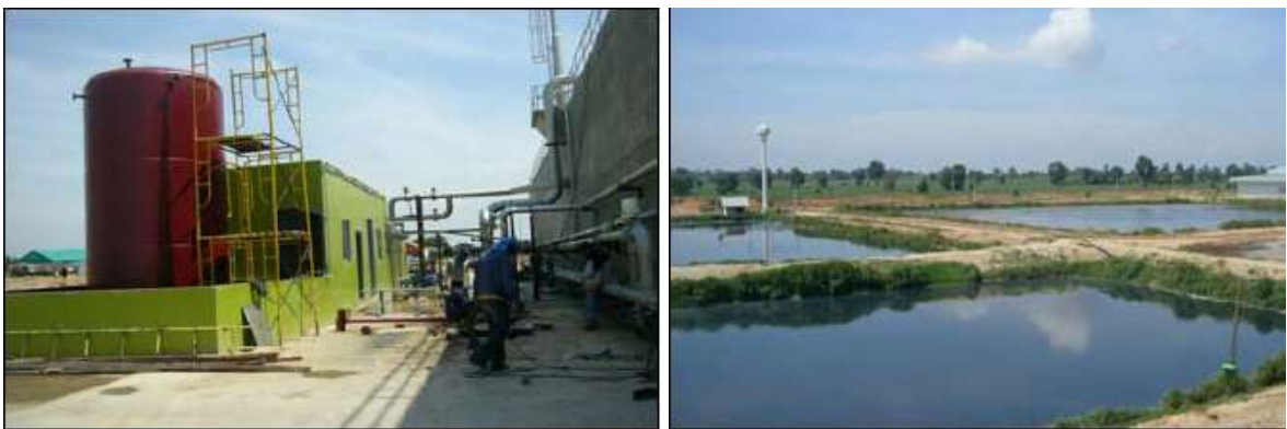
Stärkefabrik (oben), Abwasserbehandlungsanlage (unten links) und ehemalige Klärbecken (unten rechts) Quelle: South Pole Carbon
