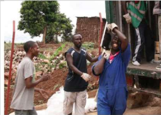
Bild 1: Entladung der Materialien für den Save80-Ofen
