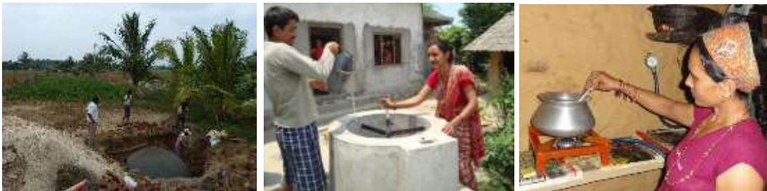
Biogasanlagen im Bau und im Einsatz, Kochstelle mit Biogas
