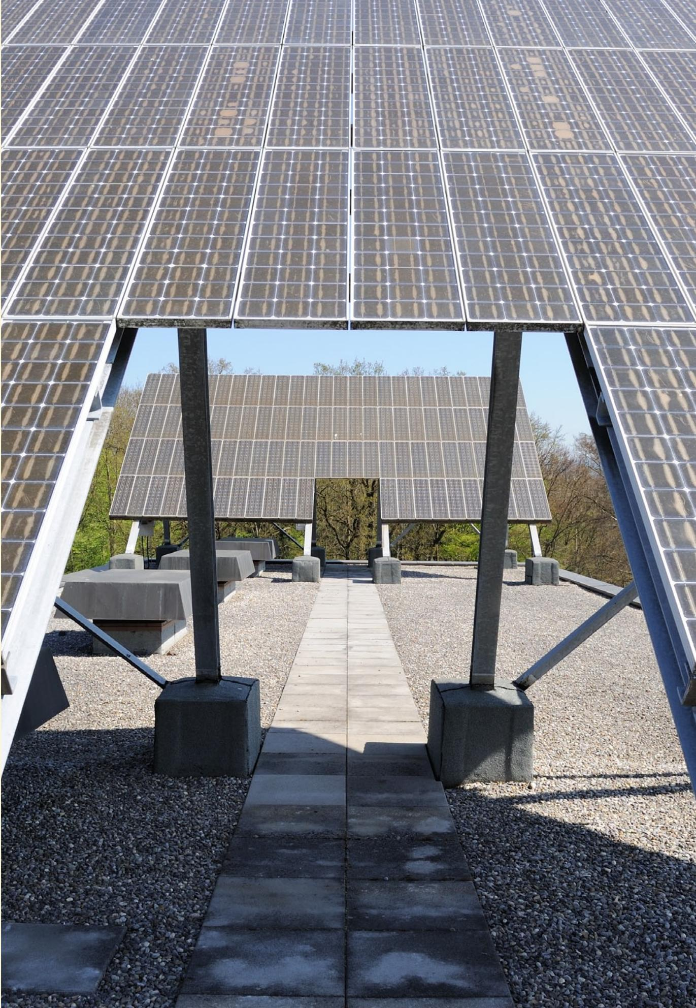
Die Solarstrom-Anlage auf dem Dach des Bundesamtes für Metrologie (METAS) produziert seit 22 Jahren zuverlässig Strom. Nach über 20 Betriebsjahren lag 2010 der Ertrag nur wenige Prozent unter der Produktion nach der Inbetriebnahme.
